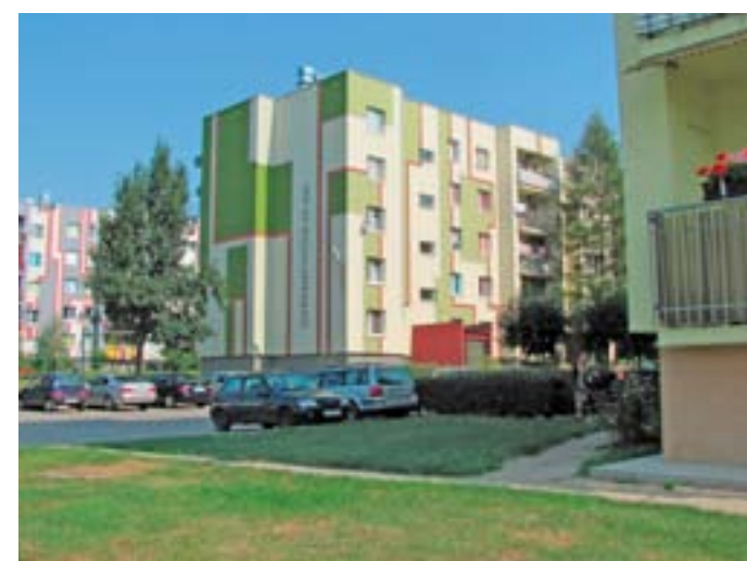
Osiedle „Piastów III” po termomodernizacji
