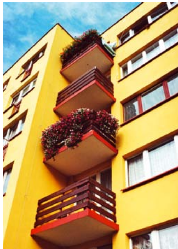
Budynek Pl. Lompy, 2000 r.
