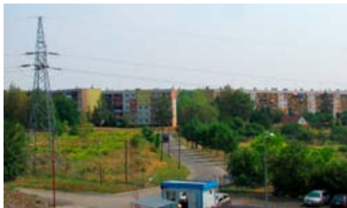
Widok z kotłowni PEC Luban na osiedlu Piastów II, 2015 r.
